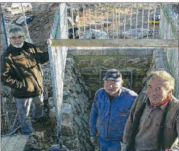
Le maire Moïse Goureau passe tous les jours sur le chantier où s'activent Dominique Bracquemond et Gérard Devaud
