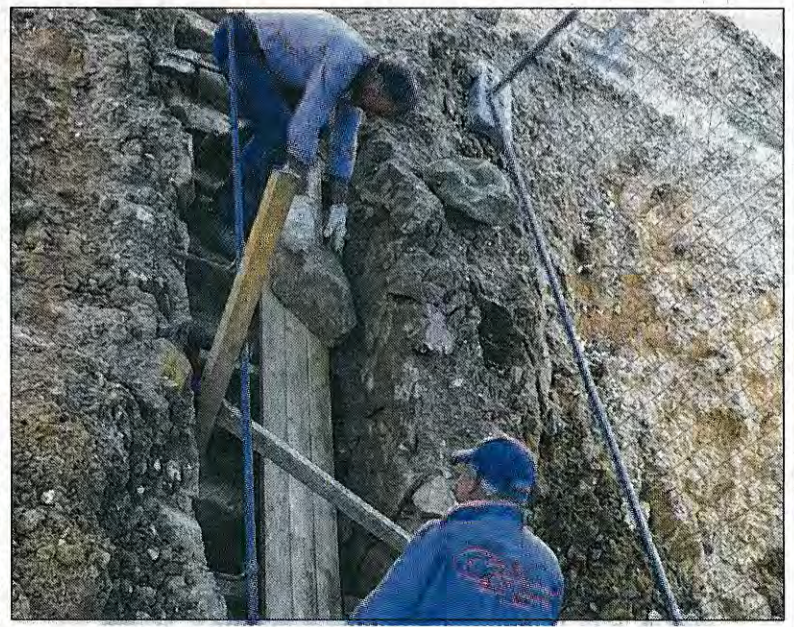
Les bénévoles ont confectionné un toboggan pour descendre les pierres en grès
