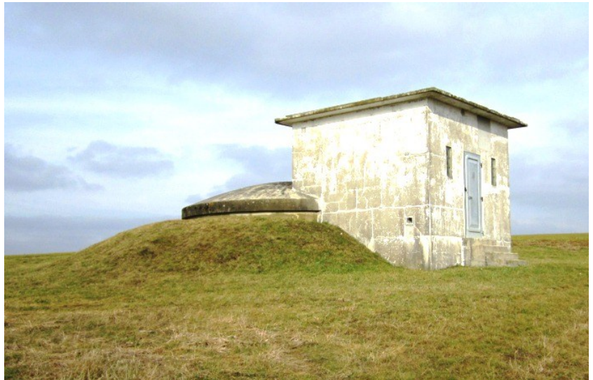
Réservoir, chemin de Justice
