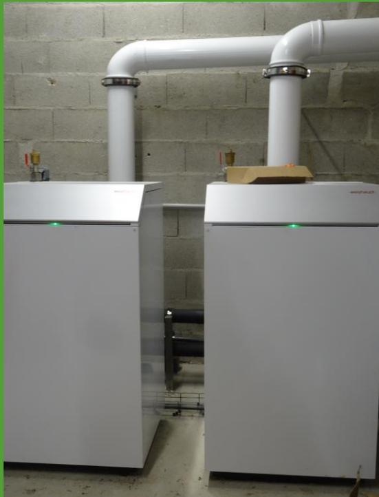
**Système de chauffage** : 2 chaudières, il faut monter à 50 degrés et non 40 degrés autrefois . Plus c'est chaud plus il y a de productivité
