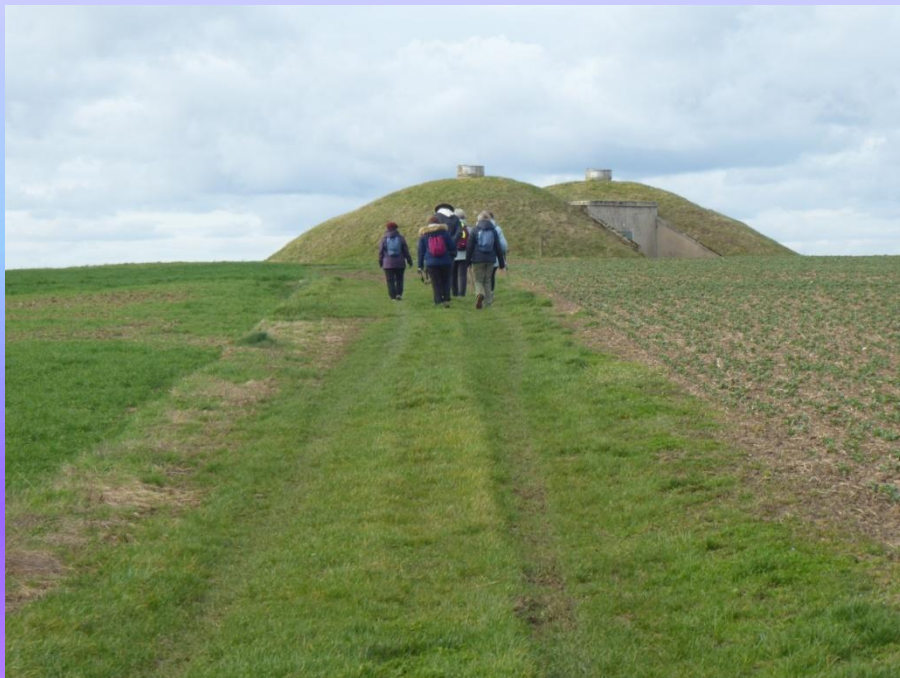
L'ancien château d'eau.
